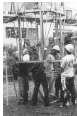
図6 トラス部品搭載作業
