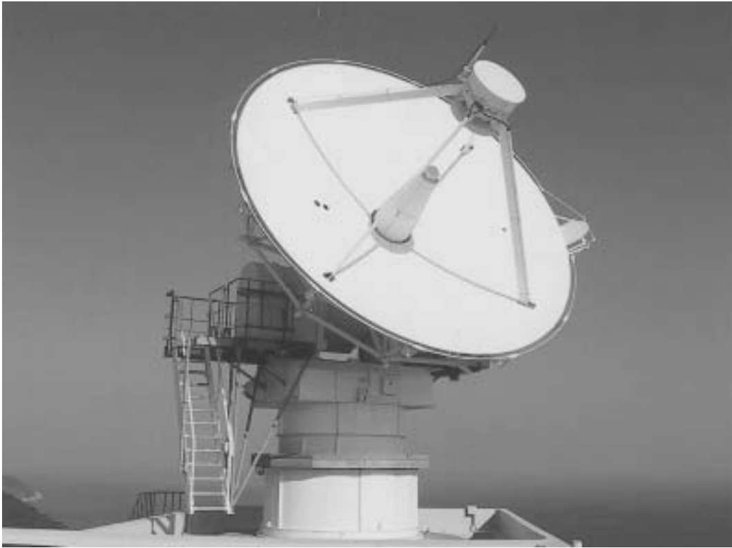
図2 新精測レーダアンテナ外観写真
