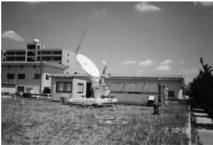
図2 宮崎ダウンレンジ局設置状況 (宮崎大学構内, M-V-3号機)
