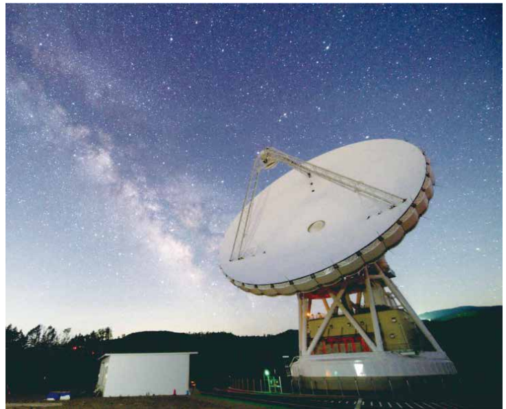
(図3) 美笹深宇宙探査用地上局54mアンテナ(長野県)。
