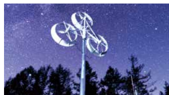
10月に完成した風力発電設備。
