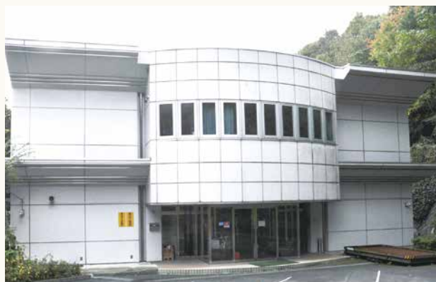
あきる野実験施設の外観。
