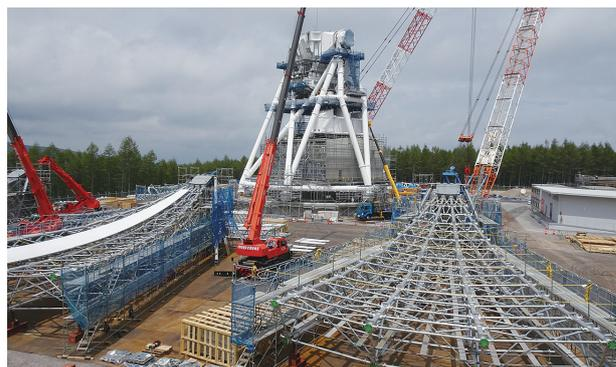
図4 主反射鏡リブの地組の様子。
