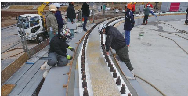
図1 アンテナレール据付工事の様子。
