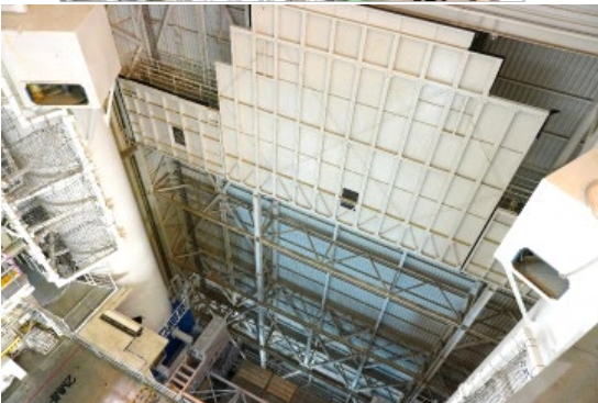
図 4-5. VAB2 高層棟. 上: 上を見上げている. 特徴的な (ロケットがすっぽり収まる) 形の昇降床越しに見える天井は開閉式で, クリーンルーム運用時は閉じる. 下: 下を見下ろしている. けっこう怖い. 写真上部に映る, 跳ね上げ式の仕切扉はクリーンルーム運用時に閉じ, これより上がクリーンルームとなる.
