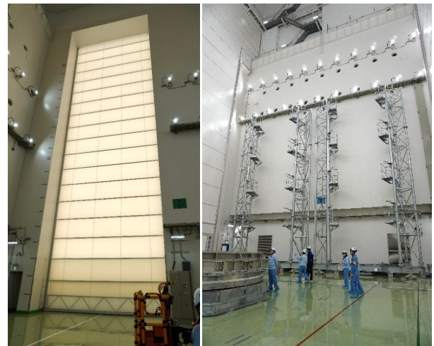
図 4-2. SFA3 室内の様子。左：エアロック室と外を繋ぐ大扉。SFA3 はシートシャッターを採用。右：フェアリング組立室。フェアリング組み立て作業台不要の設計になっている。左奥はペイロード組立室に繋がっている。
