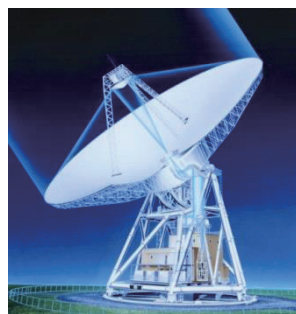
図2 直径64 [m]の パラボラアンテナ
