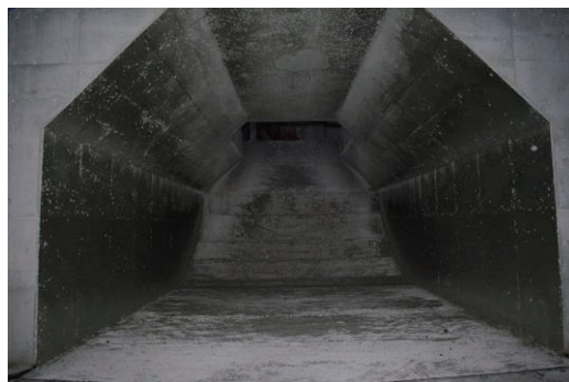
音響振動の緩和(乗り心地大幅アップ) に大きく貢献した煙道(打ち上げ後)
