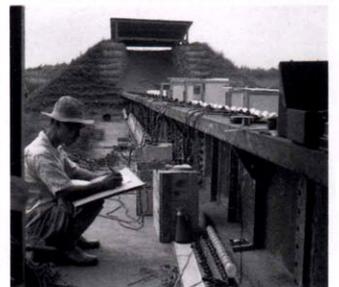
この後発射の舞台は秋田県の道川海岸に移る。道川での歴史的な第1回実験は、ペンシル300の斜め発射であった。8月6日14時18分に発射されたペンシルは、イグナイターが発火した時、その小さな噴射で尾翼を支えていたビニールテープが外れ、ランチャーから砂場へ転げ落ちて砂浜をねずみ花火のようにはい回った。
