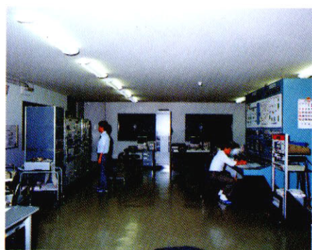
▲スペースチェンバー制御室(2階)
