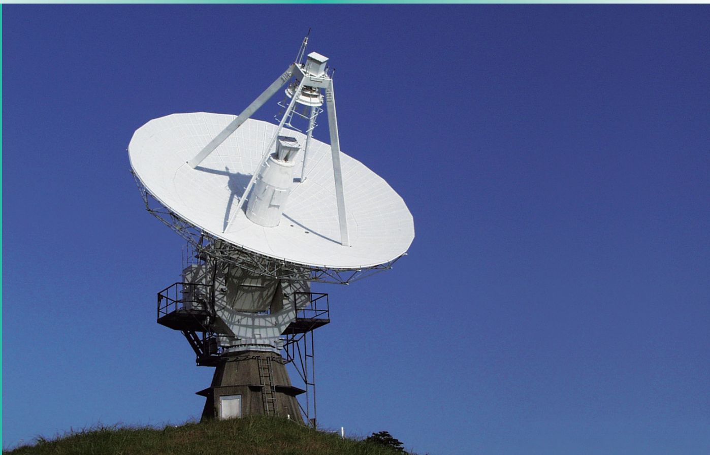
内之浦局の10mアンテナ。2011年6月をもって引退した。
