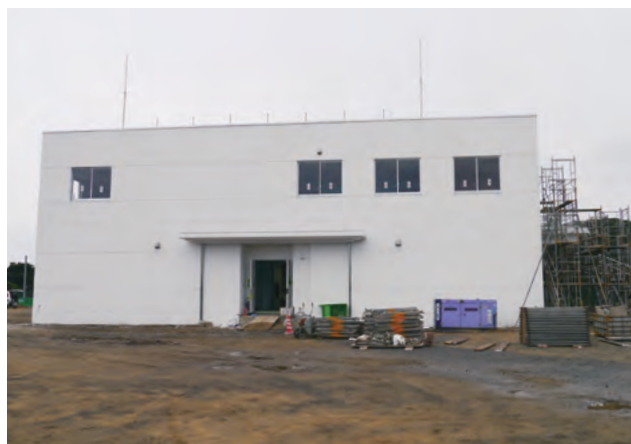
図1 完成間近のイプシロン管制センター (ECC)
