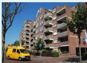
写真2 アパート外観。借りていた部屋は5階。写っていないが写真左手は小さな運河が流れており、ボートが行き交っていた。
