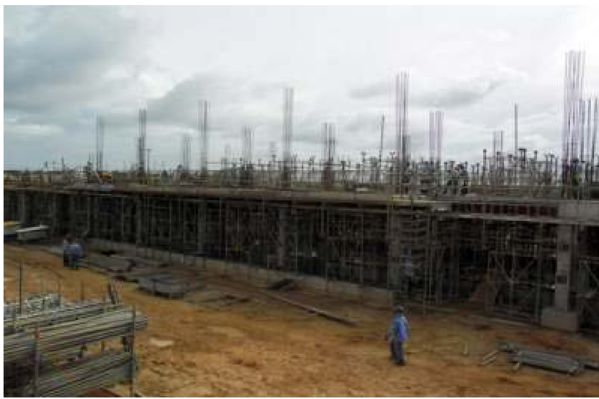
図 5: Alcantara 打ち上げ場の工事の様子 Alcantara HPより
