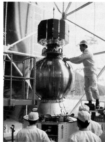
衛星の第3段球型モータへの取付作業風景
