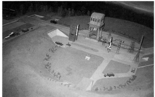
V-2射点の地形模型。小高い土手に囲まれた射点では、燃焼試験のスタンドが一際目立つ。
