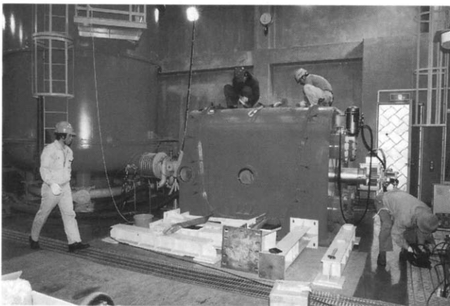
あきる野施設HATS（真空槽とバッファタンク）
