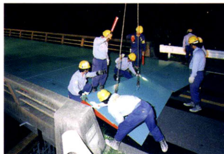
オーバブリッジの設置
