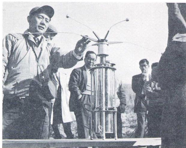
K-8型ロケット搭載の電子密度測定プローブ
