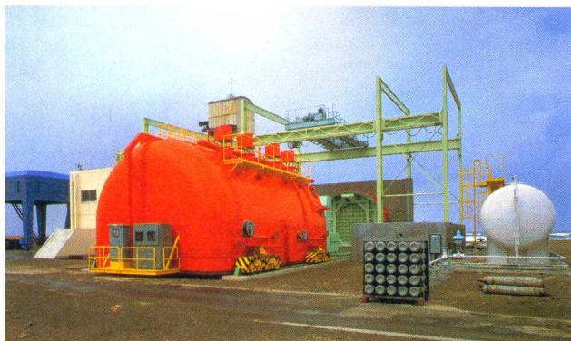
高空性能試験設備（竣工部分）
