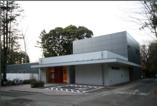
ドームシアターの建物
